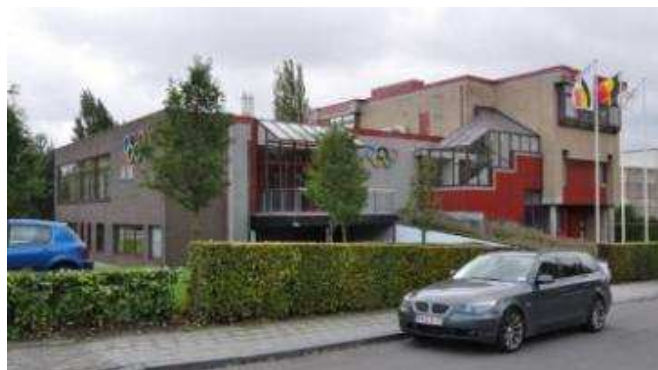
Figure 115 : Siège du COIB (APEB, 2011)
