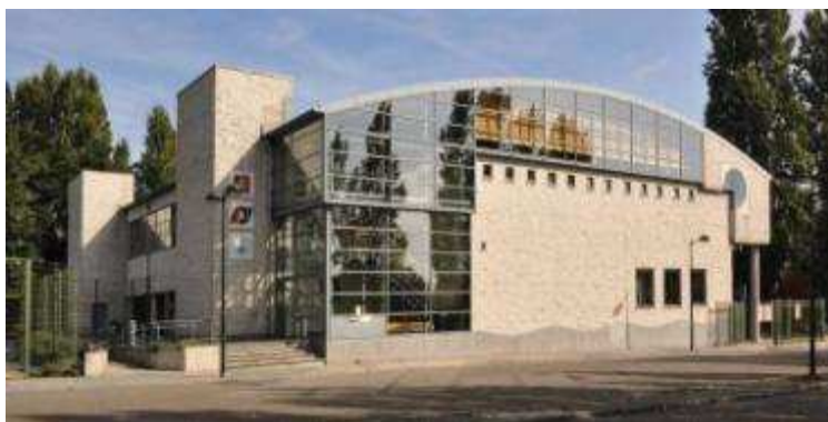
Figure 104 : Façade principale du Hall (APEB, 2011)
