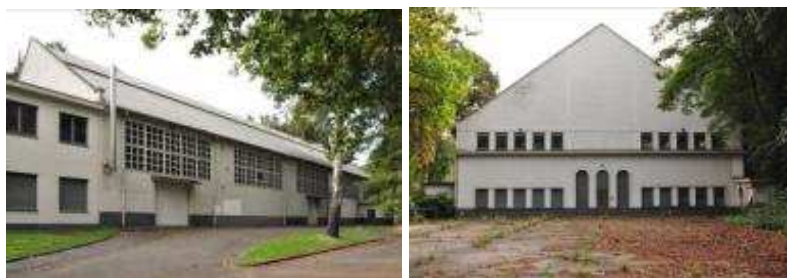
Figure 100 : Façade est et façade pignon nord (APEB, 2011)
