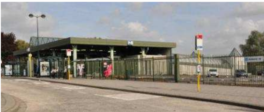
Figure 94 : station de tram et métro (APEB, 2011)
