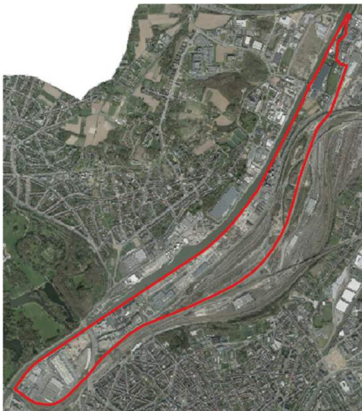
Figure 22 : Photo aérienne du site Schaerbeek Formation (Brugis, 2014)
