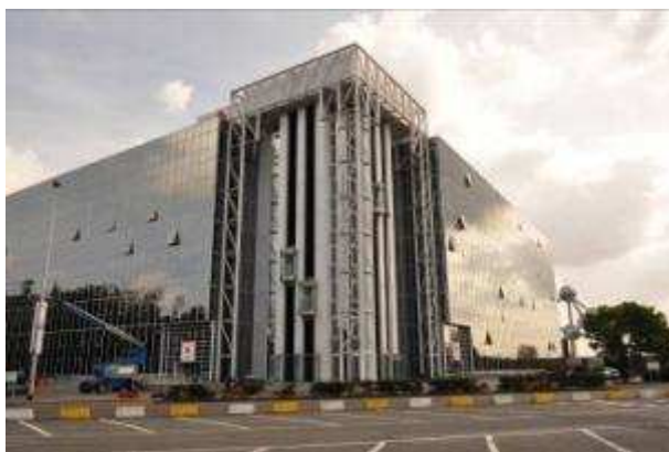
Figure 98 : Façade principale de l'immeuble (APEB, 2011)
