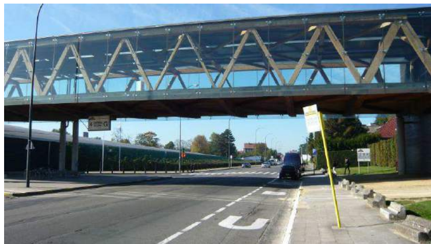
Figure 188 : Vue sur la passerelle (Google StreetView, 2014)
